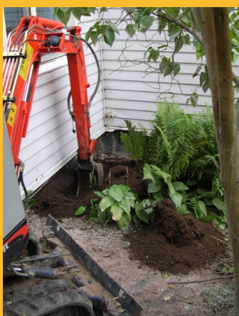
Grävning av dike fram till husvägg
