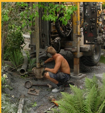
Borrning av energibrunn
